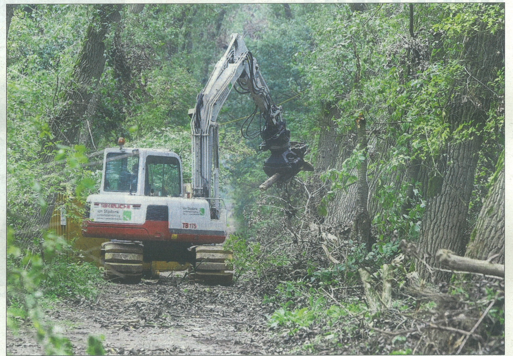
Bij het opruimen van de stormschade langs het Beatrixkanaal wordt groot materieel ingezet.
